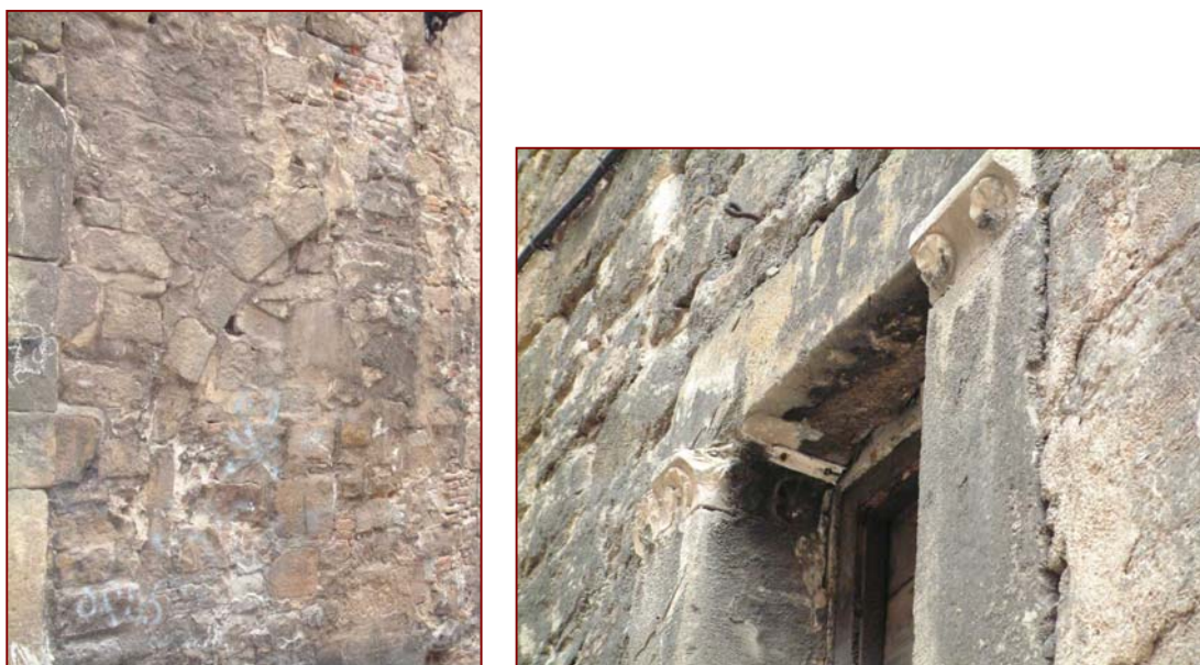
Elements arquitectònics medievals visibles a les façanes de l'edifici
